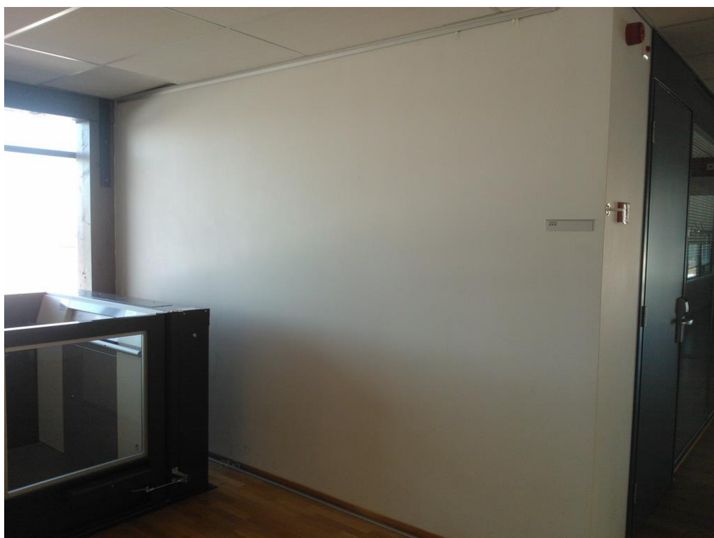
Balkongens vägg intill hissen: bredd 378cm, höjd 255cm
