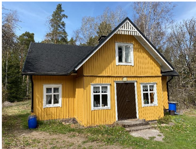
Fritidshus på fastigheten 322-412-1-19. Byggnad som hört till det gamla driftcentrumet.
