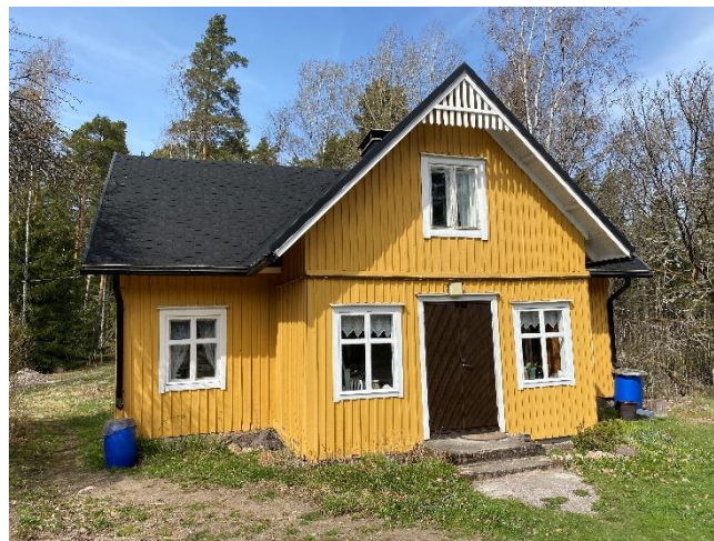
Vapaa-ajan asuinrakennus kiinteistön 322-412-1-19 alueella. Vanhan talouskeskuksen rakennus.
