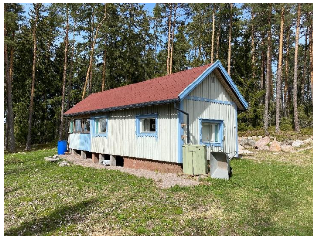
Vapaa-ajan asuinrakennus kiinteistön 322-412-1-19 alueella. Vanhan talouskeskuksen rakennus.
