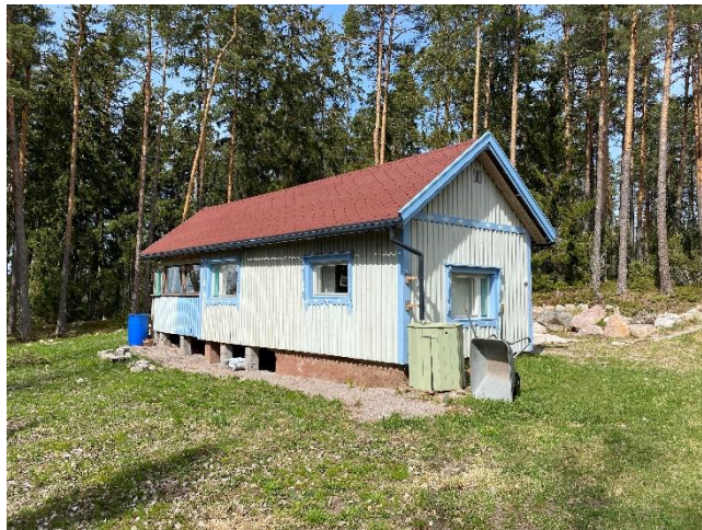
Fritidshus på fastigheten 322-412-1-19. Byggnad som hört till det gamla driftcentrumet.
