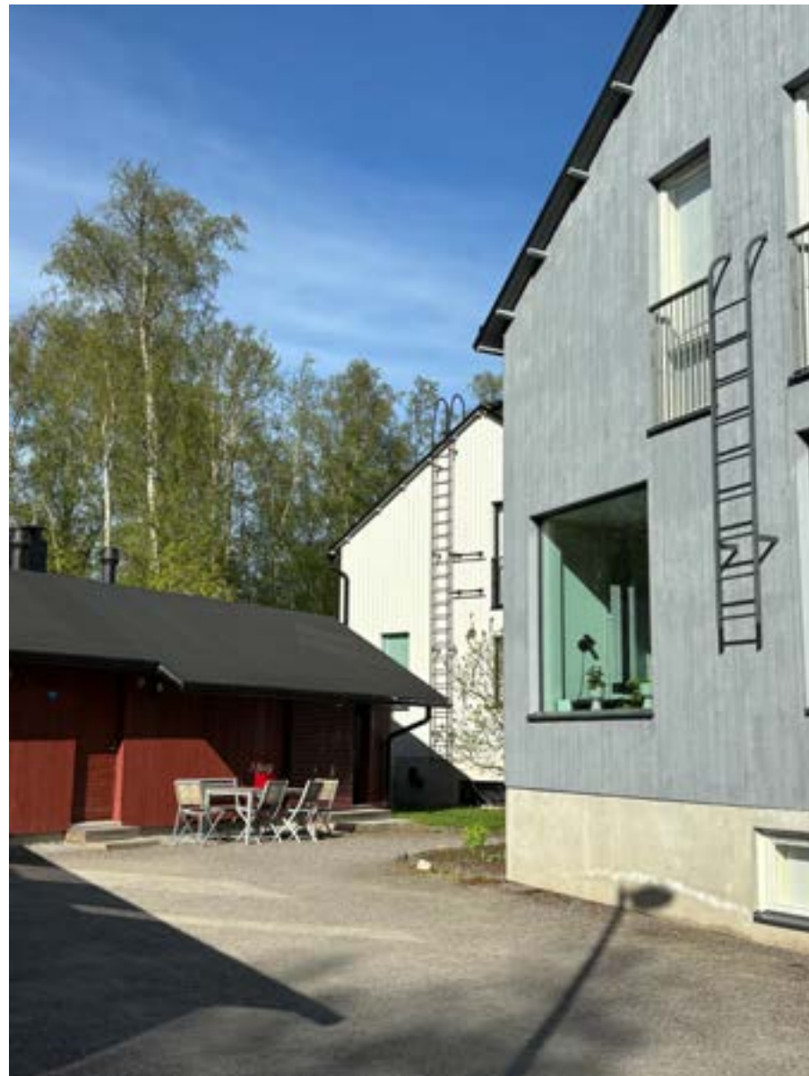
Bild 66. Beckholmen i Uleåborg. Färgvärlden och byggnadssättet har tagit intryck av befintliga gamla byggnader. Foto: Kaisa Baiardi
