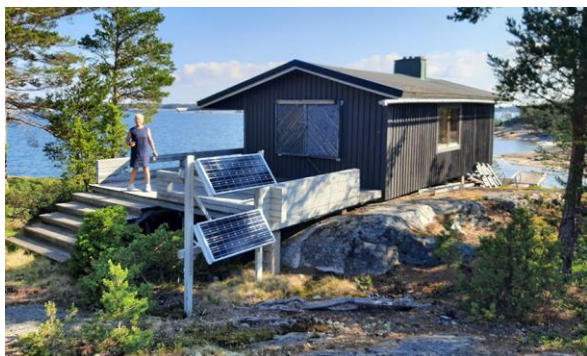
Bild 1. Fritidsbostaden, som i den gällande generalplanen är bestämd att ska rivas, anvisas i stranddetaljplanen som huvudbyggnad i kvarter 3.
