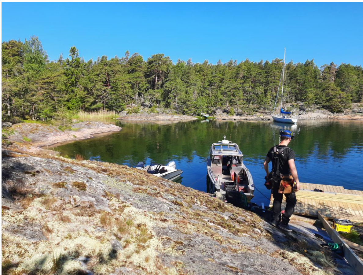
Bild 6. RA-områdets vik på den östra sidan av holmen. En ny brygga anläggs.
