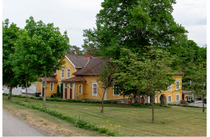
12. (sr-1) Ytterkulla, Ytterkullavägen 3, 322-501-1-207. F.d. skolbyggnad.
