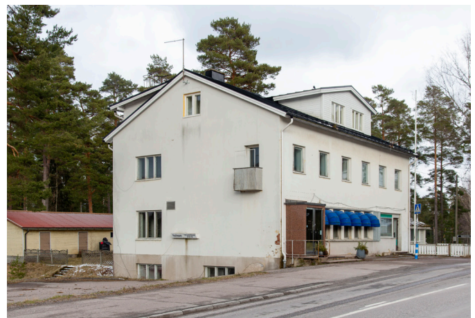
22. (sr-2) Sparbanken, Kapellbacksvägen 2, 322-502-6-1. F.d. bank- och bostadsbyggnad.
