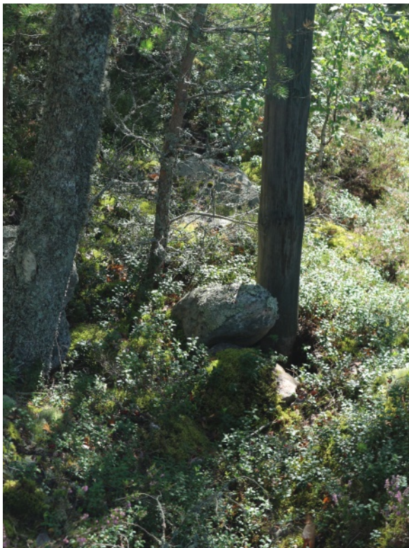
Kuva 7 (ARB2024:2:7): Sähkötolpan tukikiveys.
