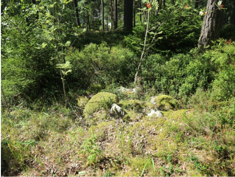
Kuva 6 (ARB2024:2:6): Sähkötolpan tukikiveys.
