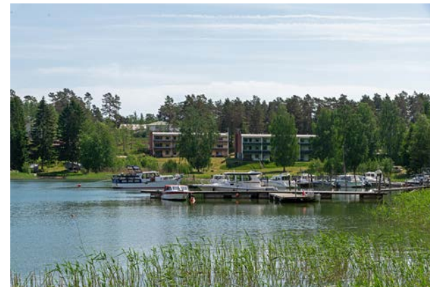
Kärä buktenin rannalla sijaitsevat kerrostalot lahden yli nähtynä.
